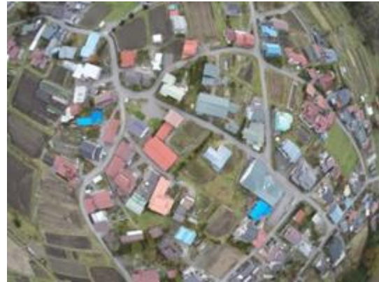
図10 長野県富士見町の大沢断層周周辺の集落
