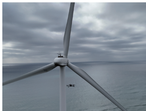
図3. 実験に用いた風車とドローン
