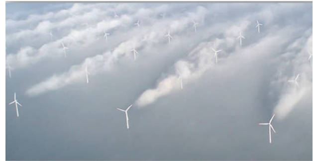
図1. 風車がより下流側の風車に与える影響 (デンマークの Horns Rev 1 ウィンドファーム)
